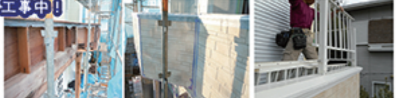
工事中！バルコニー周りとポーチ部の外壁材を剥がし、下地を新しくしました。防水シートをしっかりと施工！新しい外壁材で仕上げ後、全体を塗替えました！
