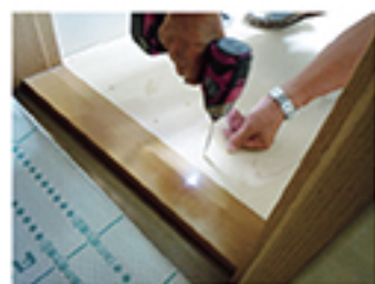
床補強+段差の解消！
