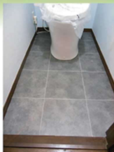
床段差解消しました！
